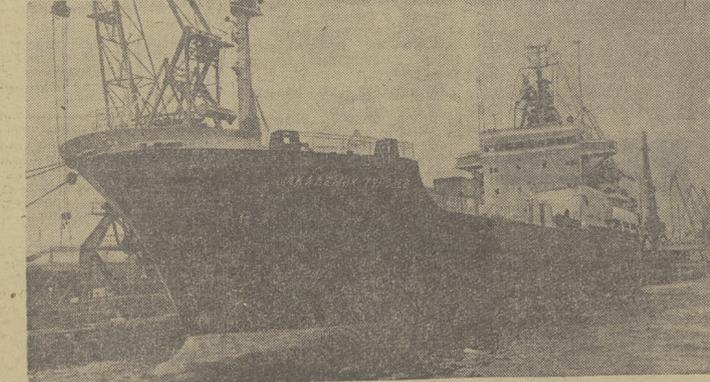
ОДЕССКАЯ ОБЛАСТЬ. Новый теплоход «Академик Туполев» ошвартовался в Ильичевском морском торговом порту. Это судно с горизонтальным способом погружения построено фирменными корабельными и предназначено для перевозки контейнеров, автомобилей, трейлеров. На двух грузовых палубах теп-
