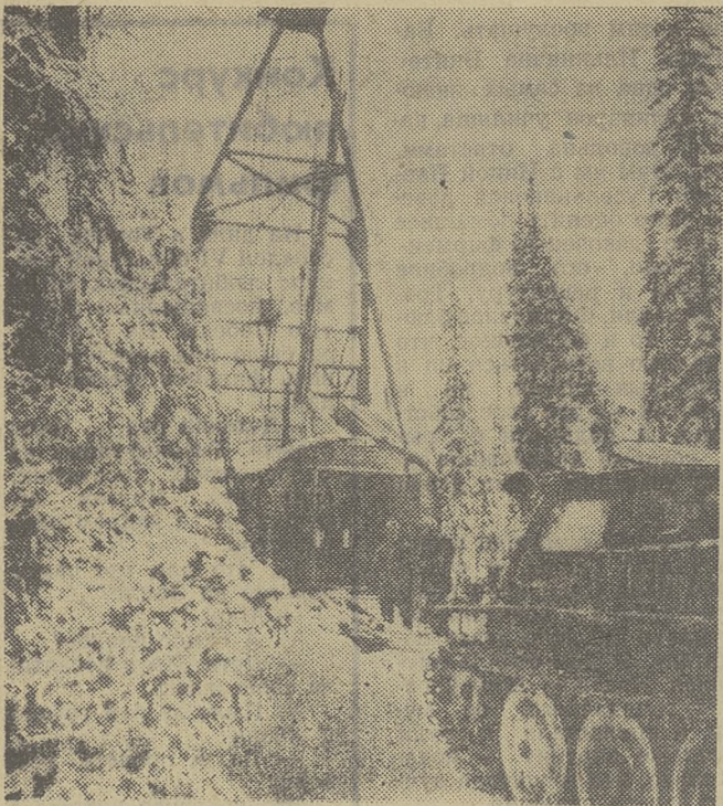
КОМИ АССР. На Среднем Тимане, в двухстах километрах от северного города Ухты, работает Четская геолого-поисковая партия. В лесной тайге открыто богатейшее Восточно-Европейское месторождение бокситов — ценного сырья для производства алюминия. НА СНИМКЕ: бурение разведочной скважины. За работой бригады бурового мастера Ивана Янина. (Фотохроника ТАСС). Фото С. Губского.
