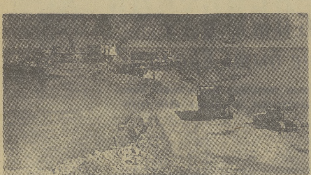
КРАСНОЯРСКИЙ КРАЙ. В Саянских горах возводится крупнейшая в мире ГЭС проектной мощностью 6,4 миллиона киловатт. В 1978 году она даст электроэнергию.
