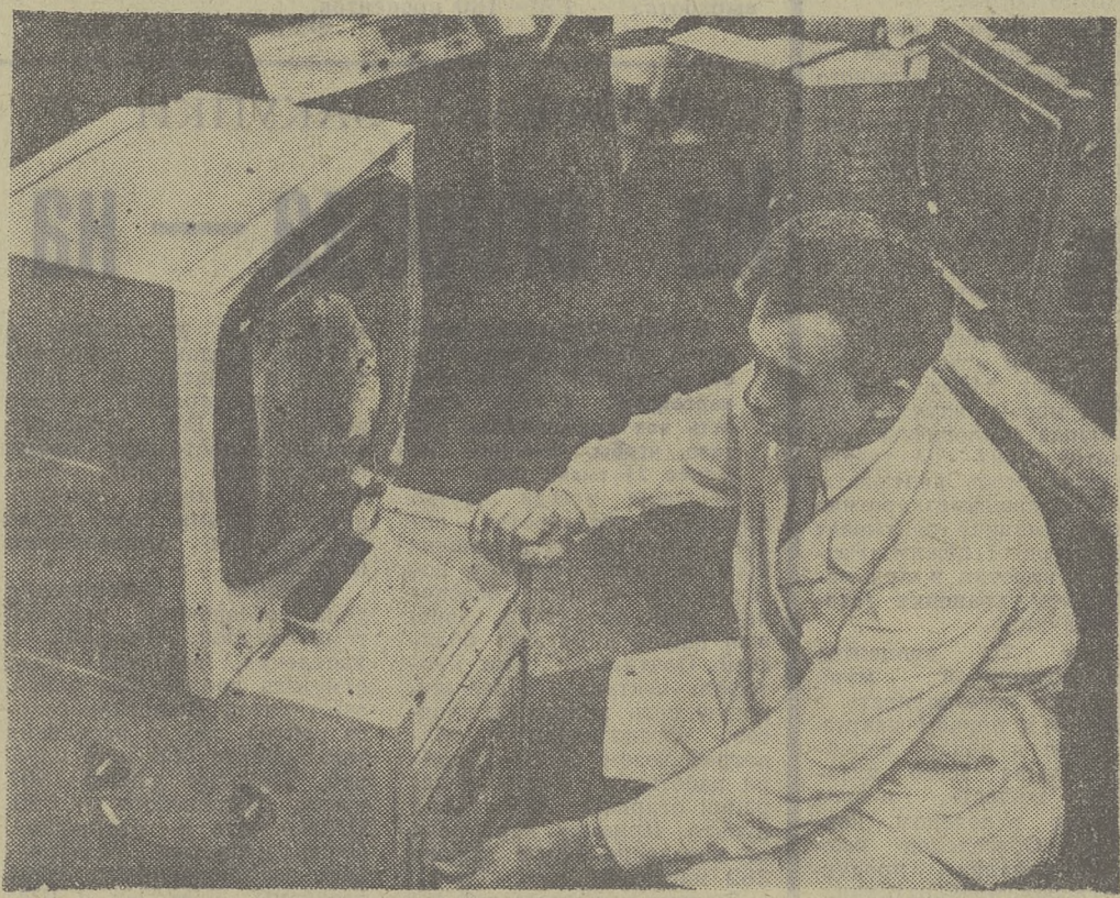
В лаборатории рентгеновской интроскопии создаются приборы, которые позволяют просматривать на экране промышленной телевизионной установки скрытые в металле дефекты. НА СНИМКЕ: заместитель заведующего лабораторией рентгеновской интроскопии А. Д. Максименко ведет эксперимент. Фото Е. Лисицына.
