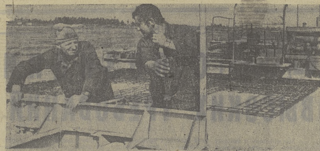
Хорошо трудятся на реконструкции участка взлетно-посадочной полосы Томского аэропорта машинист укладочной машины М. П. Коновалов и машинист отечественной машины А. В. Дурнев из управления «Химстрой». Оба они ежедневно перевыполняют сменные задания при отличном качестве выполненных работ. НА СНИМКЕ (слева направо): М. П. Коновалов и А. В. Дурнев. Фото В. Казацева.
