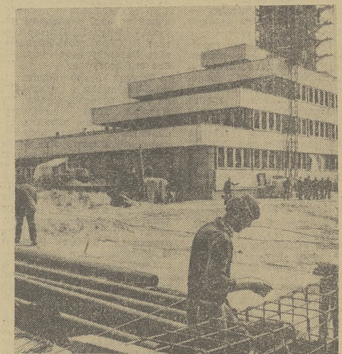
ВЕНГРИЯ. Передача радиостанции Комуна строится в районе Шольта при содействии советских специалистов. Высота радиомачты составит почти 300 метров. НА СНИМКЕ: на строительной площадке. (Фото МТИ—ТАСС).
