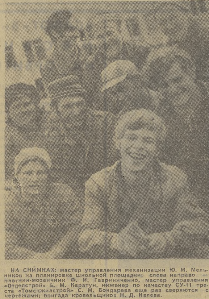
НА СНИМКАХ: мастер управления механизации Ю. М. Мельников на планировке школьной площадки; слева направо — плотник-мозаичник Ф. И. Гавриленко, мастер управления «Отделстрой» Е. М. Караунов, инженер по качеству СУ-11 треста «Томскжестрой» С. М. Бондарев еще раз сверяются с чертежами; бригада кровельщиков Н. Д. Ивлева.
