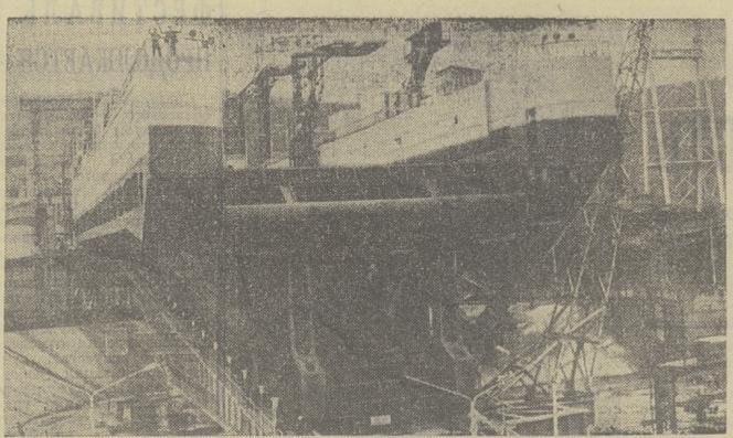
КРАСНОЯРСКИЙ КРАЙ. На Битесе сооружен уникальный судоподъемник, который обеспечит трагическое судостроение в обход плотин Красноярской ГЭС. Он состоит из поворотного устройства и наполняемой водой самодвижущейся судовой камеры, которая будет доставлять корабль в следующий бьеф. Сейчас проводится ходовые испытания конструкции.
