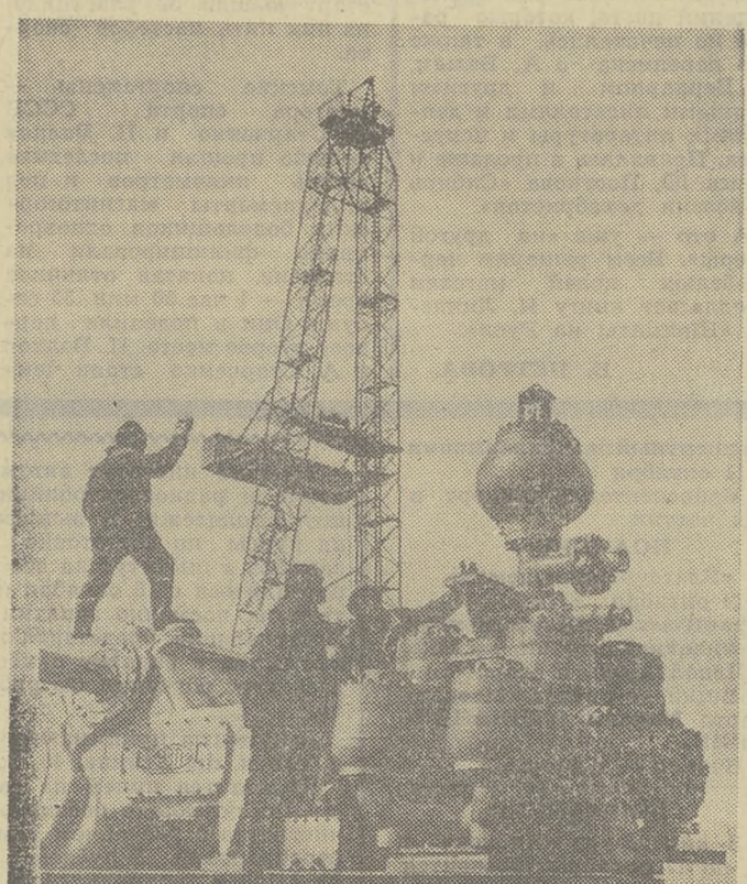
СВЕРДЛОВСКАЯ ОБЛАСТЬ. Эта буровая установка с дизельно-гидравлическим приводом предназначена для проходки сверхглубоких разведочных нефтяных и газовых скважин. Она изготовлена на Уралмашзаводе. Новый агрегат будет отправлен геологоразведчикам «Грознефть».
