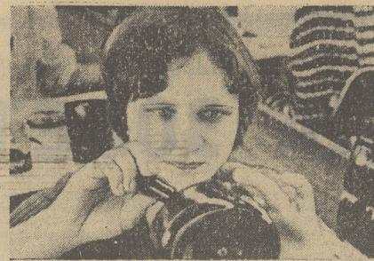
Комсомолка Т. Боровицкая — слесарь-регулирующая цеха № 5 манометрового завода. Таин — одна из передовых работниц цеха. Она освоила новый метод работы: регулировку двух манометров одновременно. Фото В. Казанцева.
