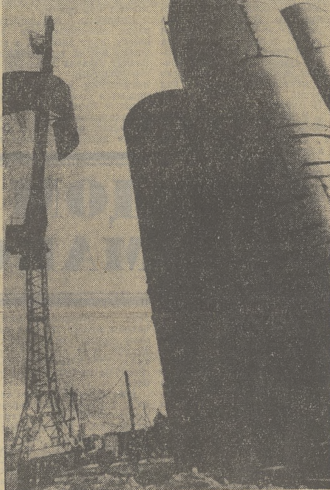
На строительной площадке нефтехимического комбината приступили к возведению цехов по производству полипропилена. Это будет первая фабрика строящегося гиганта нефтехимии. Сейчас строители химкомбината завершили возведение первых объектов базы стройиндустрии комбината.
