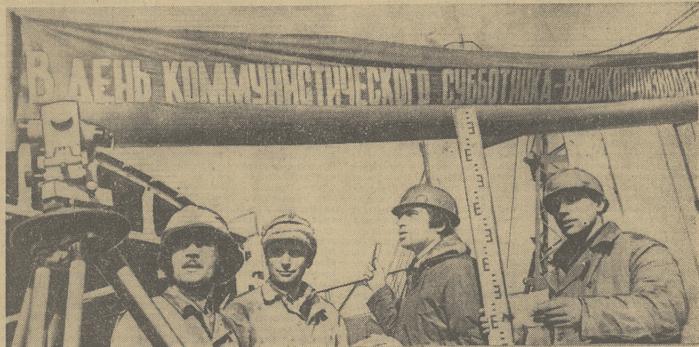
По-ударному прошел Всесоюзный ленинский субботник на строительной площадке Томского нефтехимического комбината. Монтажные СМУ-11 Химстроя, воз-
