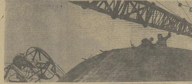
Обустройство Вакского нефтяного месторождения продолжается. Один из важнейших этапов этой большой работы — строительство двух огромных, каждый емкостью по 5 тысяч кубометров, резервуаров для хранения «черного золота».
