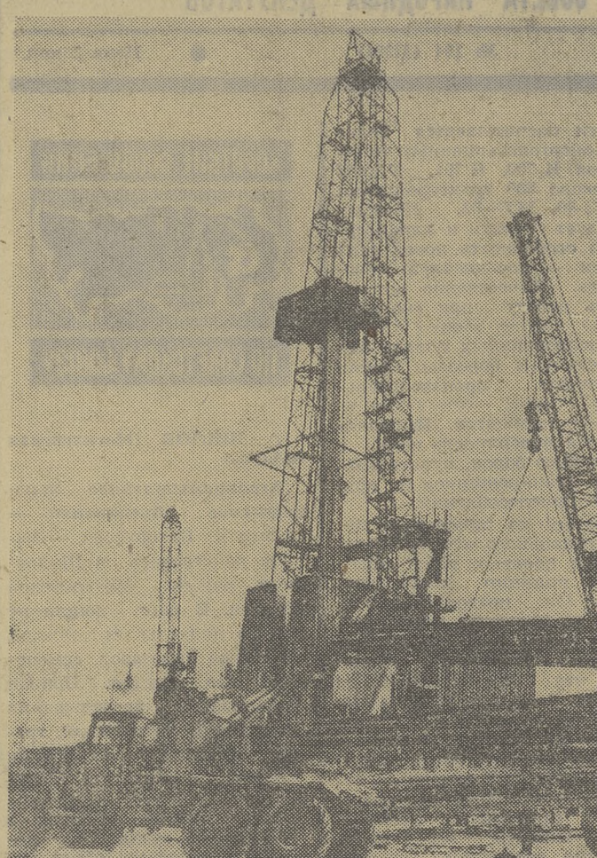
На освоении нефтяных месторождений нашей области стали применяться новые буровые установки «Уралмаш-3000 ЭУК» (электрическая, универсальная, монтажно-обслуживающая для кустового бурения).
