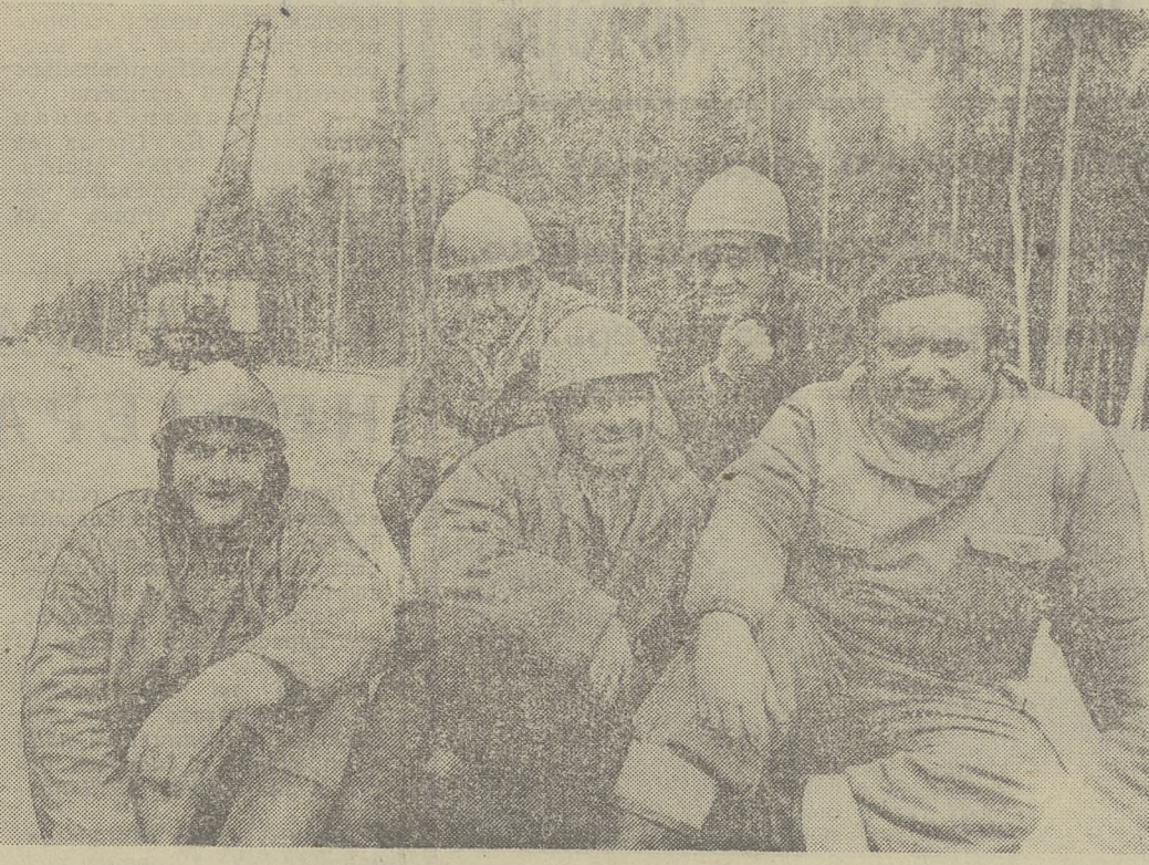
Монтажное звено Александра Ворошилова из УМС-8 треста «Казафторстрой» ведет монтаж бетонной дороги на Васюгане к новым нефтяным месторождениям. Хорошее настроение у коллектива: спорится работа у казахских дорожников. Четыре с половиной километра за пятнадцать
