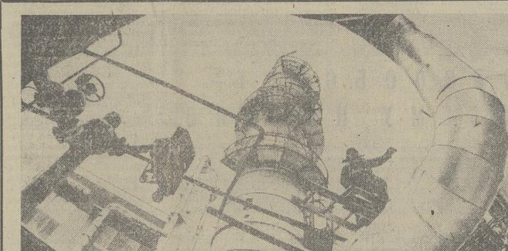
И... заматали, лампочки, заработала звуковая сигнализация, табло высвечивает — «Минимальное давление оборотной воды».
