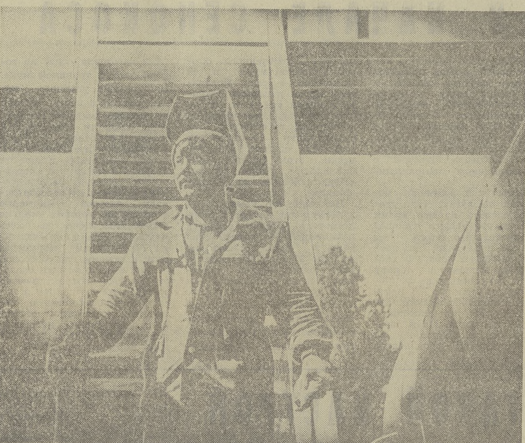
Третий год трудится на обустройстве нефтяного промысла Вах в Александровском районе монтажник Николай Пошицкий. Сейчас с коллективом бригады СМУ-3 треста «Томскнефть» он заканчивает сооружение еще одной насосной, которая обеспечит прирост добычи нефти.
