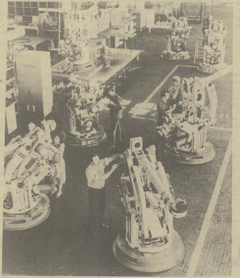
ТОЛЬЯТТИ (Куйбышевская область). В объединении «АвтоВАЗ» действует крупный цех по производству автоматических помощников — роботов. Недавно начато серийное производство новых роботов многоцелевого назначения «Ветта». Они могут успешно трудиться на участках сварки, механической обработки деталей, на окраске и мойке, облегчат труд рабочих на транспортных операциях, переноса грузов весом до 100 кг. Сегодня новым роботам доверена работа в составе сварочных комплексов.
