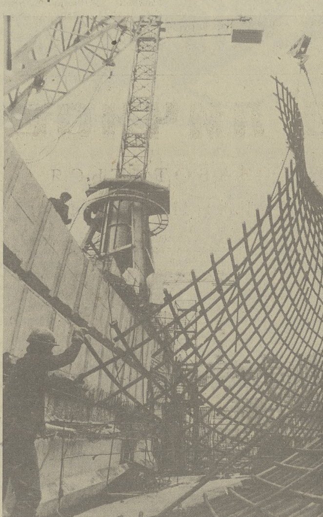
Третья ГЭС Иртышского каскада
