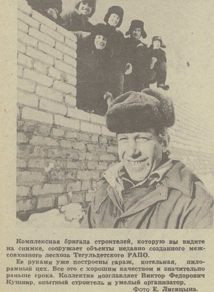
Комплексная бригада строителей, которую вы видите на снимке, сооружает объекты недавно созданного межсоюзного лесхоза Тегульдского РАПО.
