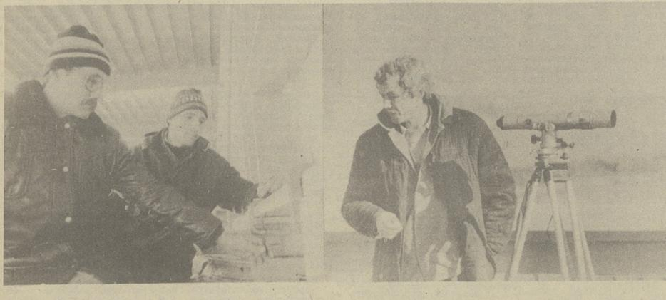
— Пошла нагрузка! — махнул рукой руководитель испытаний Борис Михайлович Бериги, и тотчас на дорожное полотно моста двинулась колонна яро-оранжевых «НамАЗов», груженых щебнем. Суммарный вес армды из 32 машин — около 700 тонн. Сейчас они расположены на двух пролетах в центре моста, и чувствительные приборы выявляют все изменения в прогибе и напряженности конструкций.
