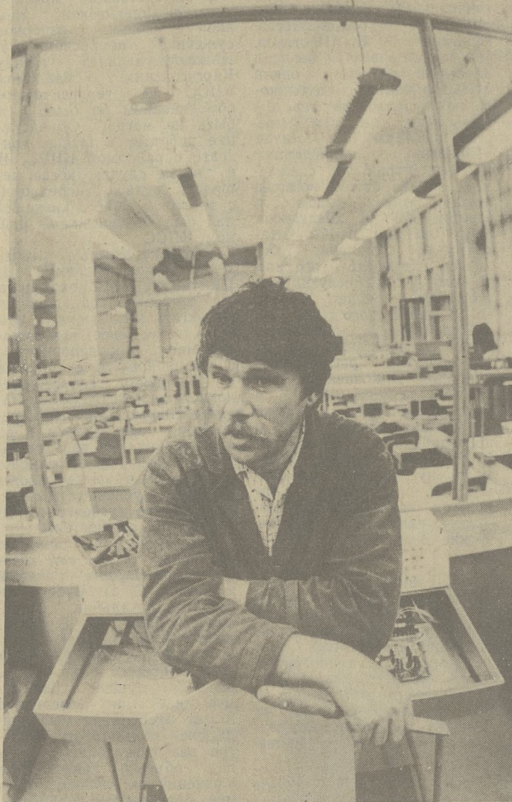
Завершен монтаж линии
