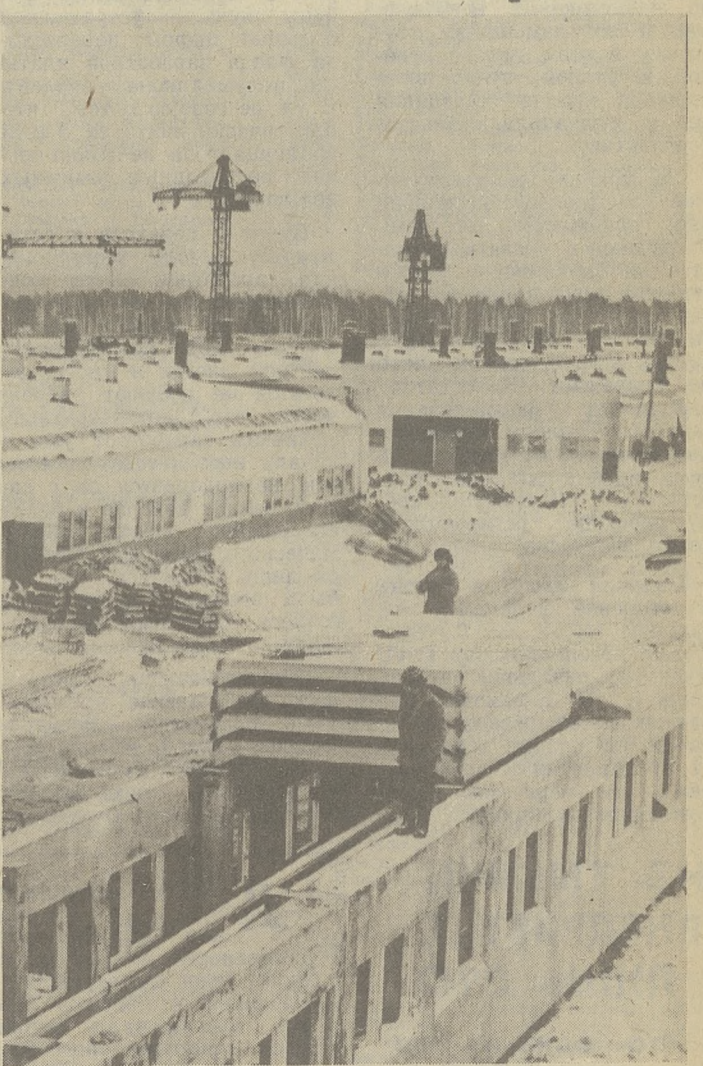
НА СНИМКАХ: монтажники «Сибстальконструкции» А. Тихонов и В. Сапронов; на строительной площадке. Фото Е. Лисицына.
