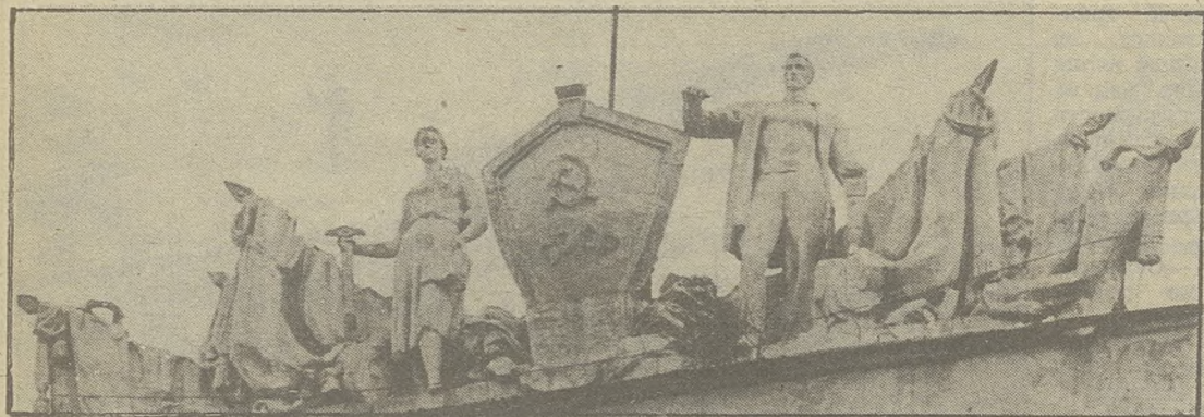
Крыша 10-го корпуса ТПИ.
