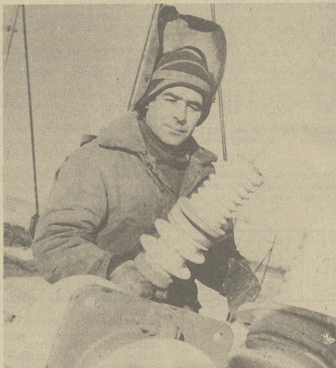
Михаил Федорович Ушаков руководит бригадой электромонтажников в специализированном строительно-монтажном управлении. Прокладка линий электропередачи, разводка кабелей на нефтепромыслах — вот основная работа коллектива. Большой вклад внесла бригада М. Ушакова в строительство установки предварительного сброса воды.
