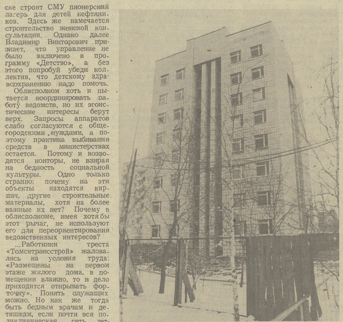
Так выглядит готовящееся к сдаче под ключ административное здание треста «Томсктрансстрой».
