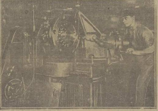
На снимке: установка зуборезного американского станка последней конструкции сист. «Гриссон», который нарезает вместо прямого зубца конический или ральный, что дает меньшую изнашиваемость и более ровный ход. С первого января все зуборезное отделение переходит на положение производственной коммуны, в которую вошли мастера и инженер.
