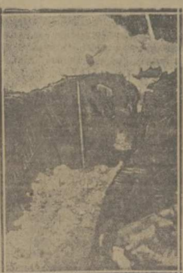
Проводят канаву для приема воды для маниторных работ (прииска), прииска «Семеновские Лог».
