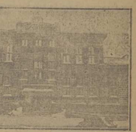
Здание кемеровского рудоуправления передается под школу горняков. Здесь вместо канцелярий будут мастерские, общежитие и классные комнаты. Сейчас заканчивается ремонт этого дома.
