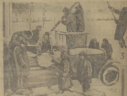
Вверху — устанавливают грани, определяющие место будущих корпусов завода. Внизу — разгружают бутовый камень.
