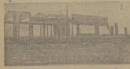
Строительство Белового цинкового за вода (Кузнецкий округ). На снимке: уста новая ферма обмывного цеха.
