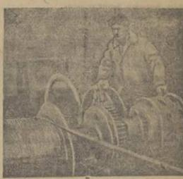
После долгих настойчивых требований ударников на комсомольской шахте Лен рудника взамен конного порота установили подъемная электрическая лебедка. Это дает возможность развозить угледобычу уклонки № 3 до 300 тонн в сутки.
