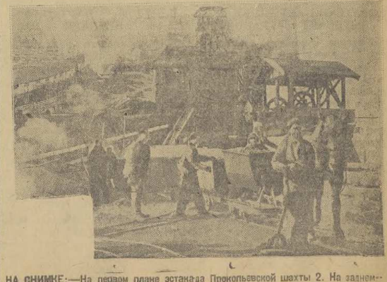
НА СНИМКЕ: На первом плане эстакада Прокопьевской шахты 2. На заднем — общий вид шахты 2 и шахты 2-бис.
