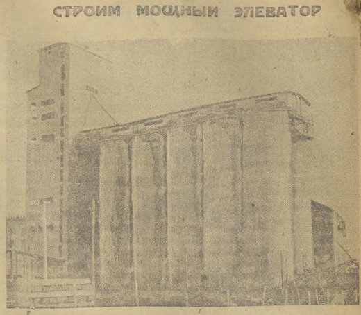
В Ново-Омске заканчиваются постройкой и к началу ссыпки нового урожая будет готов мощный элеватор вместимостью 120 тысяч тонн. На снимке: заканчивающийся постройкой мощный элеватор Союзхлеба.
