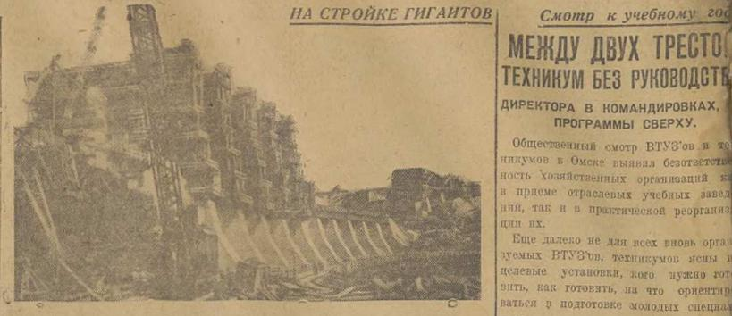
На снимке: Бетонировка бычков плотины левого берега на Днепрострое.
