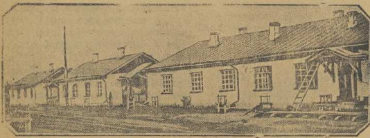
Рабочий поселок на центральном участке.
