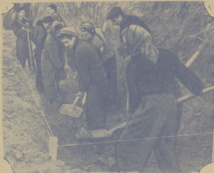
На снимке: студенты-математики на строительстве учебного корпуса. Фото В. Дубовицкого.
