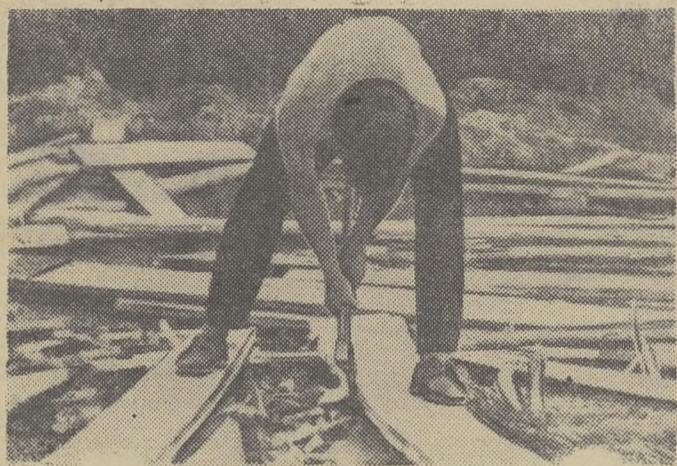
Ровнять тес — одна из ответственных строительных операций.
