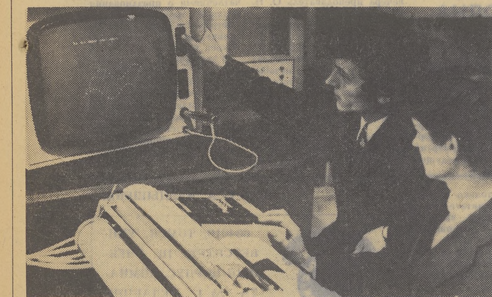
Сотрудники СФТИ за подготовкой к работе автоматизированной установки по исследованию структуры электромагнитного поля. Управляющая часть установки, изображенной на снимке, включает в себя ЭЦВМ МИР-2. Слева направо: Виктор Николаевич Ломаев и Владимир Иванович Коломеев.
