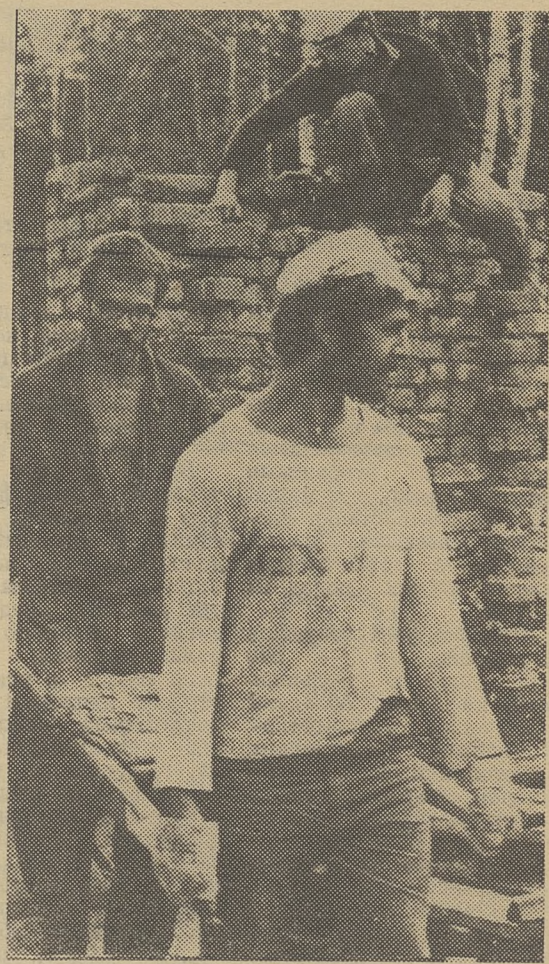
НА СНИМКЕ: В. Казаков, А. Спирин, С. Федеряков на постройке двухквартирного дома.
