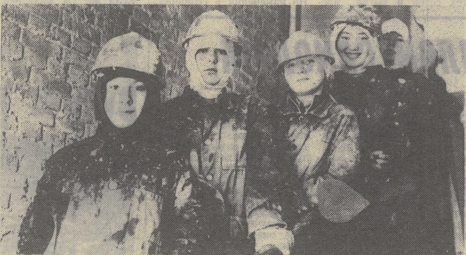
В 6-м учебном корпусе и в северном крыле главного студентами начаты штукатурные работы. На снимке, сделанном нашим фотокорреспондентом А. Семеновым в главном
