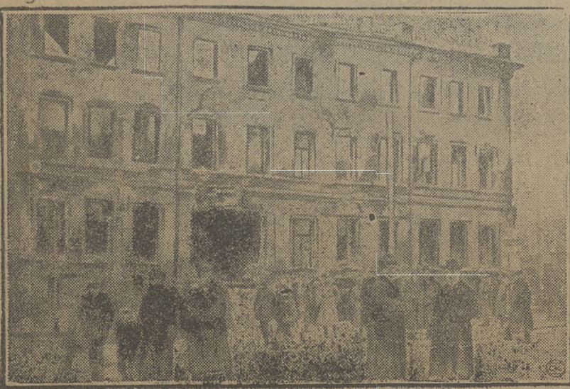
Сгоревший дом Большой Ярославской Мануфактуры по Тверскому бульвару.
