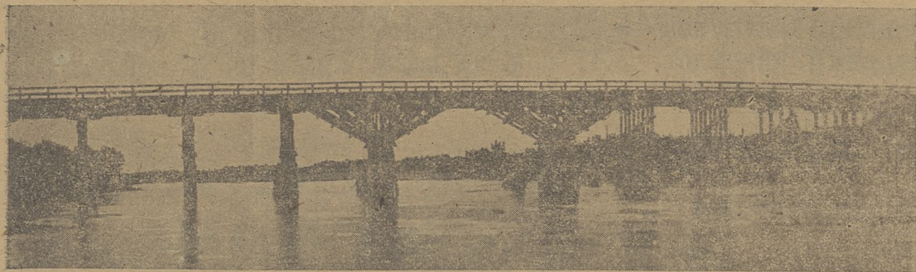
Мост через реку Тару в с. М.-Красноярском построен в июле нынешнего года. Мост стоит 18 тысяч рублей. Длина моста 96 метров, высота от дна реки 12 метров
