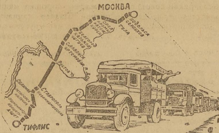
Из Москвы в испытательный пробег по маршруту Москва—Тифлис—Москва вышла колонна автомашин с дизельмоторами. В пробеге наряду с дельмоторами иностранных фирм участвуют первенцы советского автомобильного дизельстроения—дизеля „Коджу“. Пробег имеет целью выявить целесообразность и экономичность применения дизельмоторов на автомашинах. На снимке—с тарт пробег в Москве, маршрут пробегает.
