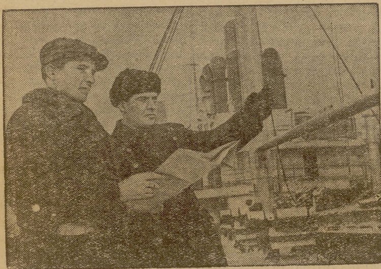
Коллектив канонерского судоремонтного завода (Ленинград) восстанавливает теплоход «Челюскин». НА СНИМКЕ: Главный инженер Г. Г. Башкиров (справа) и производитель работ П. А. Корневский обсуждают ход восстановительных работ. Фото М. Редкина.
