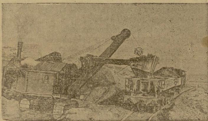
На строительстве Шекснинского гидроузла. НА СНИМКЕ: погрузка грунта экскаватором на железнодорожные платформы.
